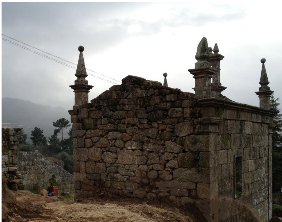
Fig. 4. Ruína da Casa de Covela. Fachadas tardez e lateral Noroeste. Fonte: Pedro Alarcão.
