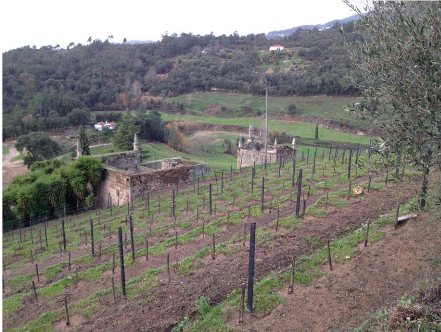
Fig. 3. Ruína da Casa de Covela. Fachadas tardez e lateral Sudeste. Fonte: Pedro Alarcão.
